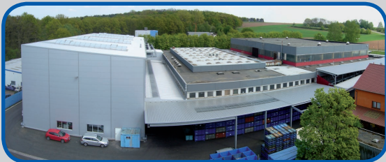
Schlüsselfertiger Neubau einer Fertigungshalle mit einer Grundfläche von ca. 1.500 m 2 und einer Hallenhöhe von ca. 15 m sowie Überdachungen mit einer Grundfläche von ca. 1000 m 2
