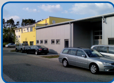
... und die angeschlossene Werkhalle als Stahlbaukonstruktion.
