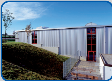
Stahlbau mit Oberlichtern, Fassade einschließlich Türen, Toren und Fenstern, Hallenkran, Innentreppen und Laufstegen
